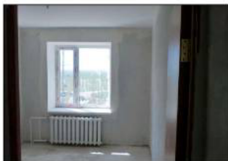
Foto 1 | Blok IV - Wejście 13/1 - Klatka 2 Apartament 22
