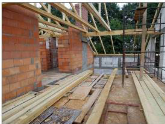
Zdjęcie 02: Stan wykończenia dachu
