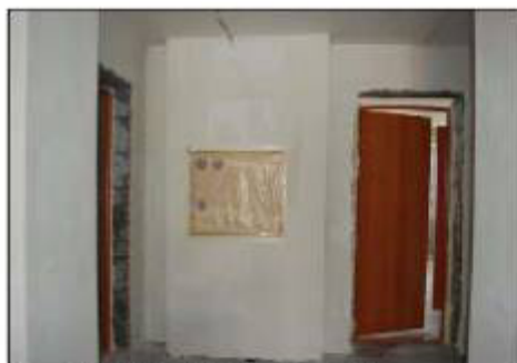
Foto 3 | Blok IV - Wejście 13/1 - Klatka 4 Apartament 46/ Klatka schodowa
