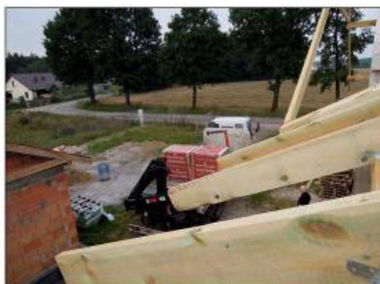
Zdjęcie 05: Stan wykończenia dachu
