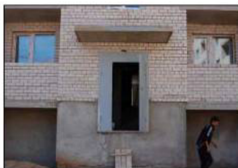
Foto 1 | Blok IV - Wejście 13/1 - Klatka 12 Wejście
