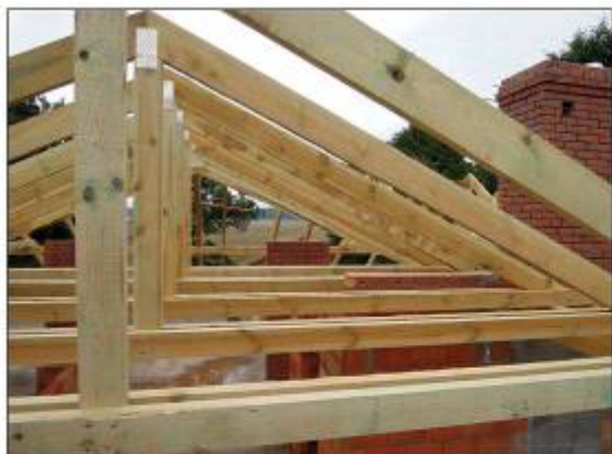
Zdjęcie 01: Stan wykończenia dachu
