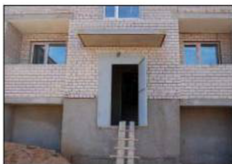
Foto 5 | Blok IV - Wejście 13/1 - Klatka 6 Wejście
