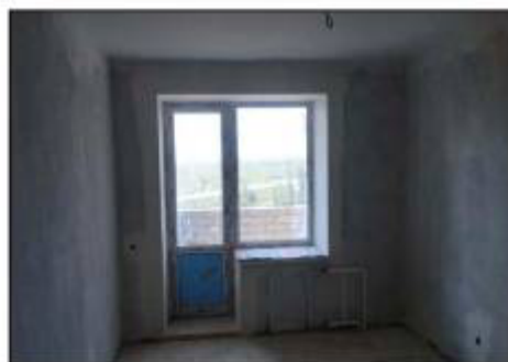
Foto 2 | Blok IV - Wejście 13/1 - Klatka 2 Apartament 25
