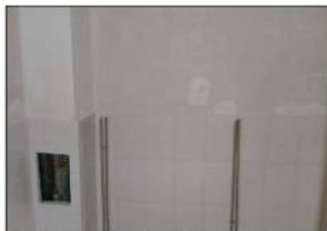
Foto 4 | Blok IV - Wejście 13/1 - Klatka 5 Apartament 55/ WC
