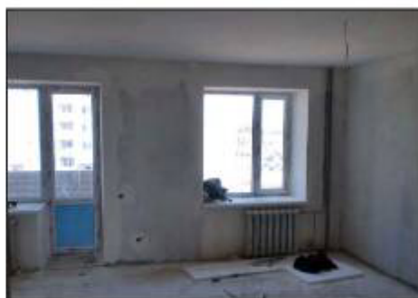
Foto 2 | Blok IV - Wejście 13/1 - Klatka 10 Apartament 104
