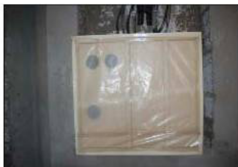
Foto 3 | Blok IV - Wejście 13/1 - Klatka 11 Klatka schodowa/ Instalacja techniczna
