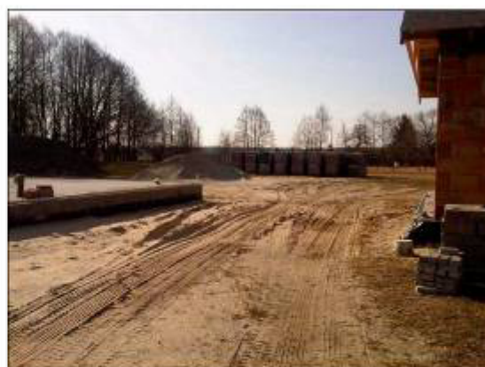
Zdjęcie 06: Stan wykończenia drogi dojazdowej
