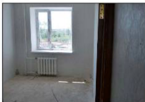
Foto 1 | Blok IV - Wejście 13/1 - Klatka 8 Apartament 84
