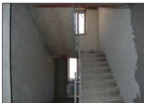
Foto 1 | Blok IV - Wejście 13/1 - Klatka 13 Klatka schodowa
